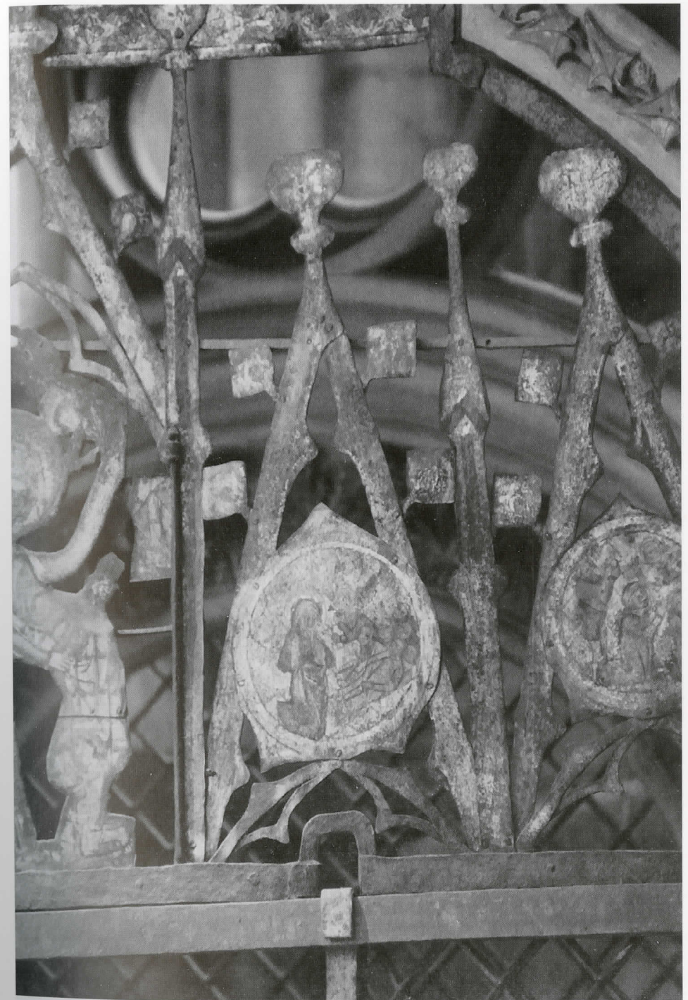
Abb. 18 Mausoleum, Vergitterung der südlichen Arkatur, Detail mit Aussparung für die mobile Vergitterung
