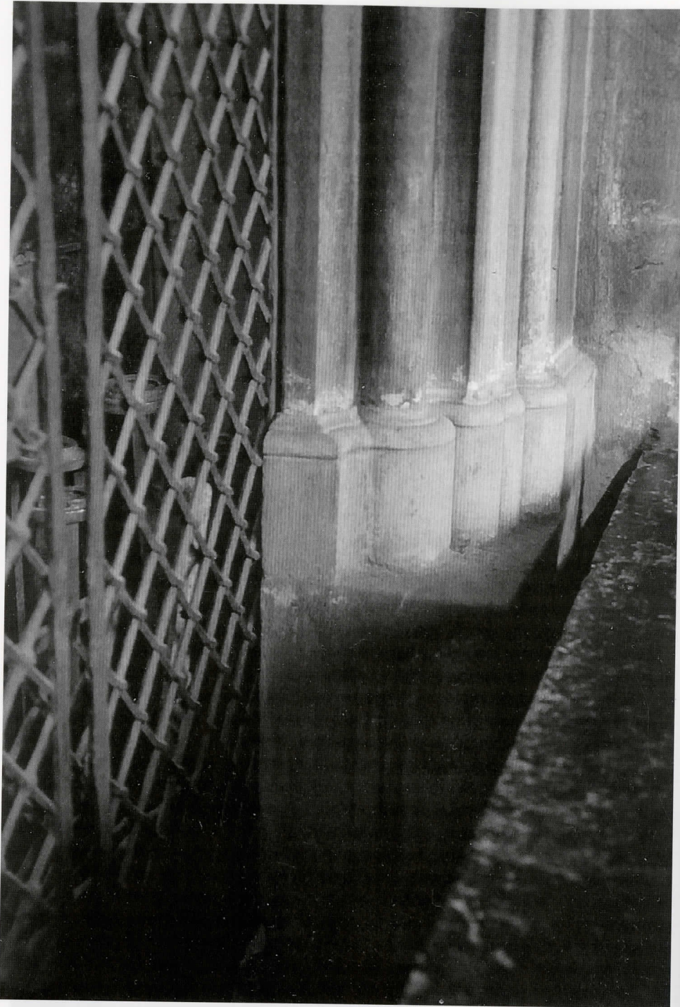
Abb. 10 Mausoleum, innere Rückseite der Architektur, Sockelbildung
