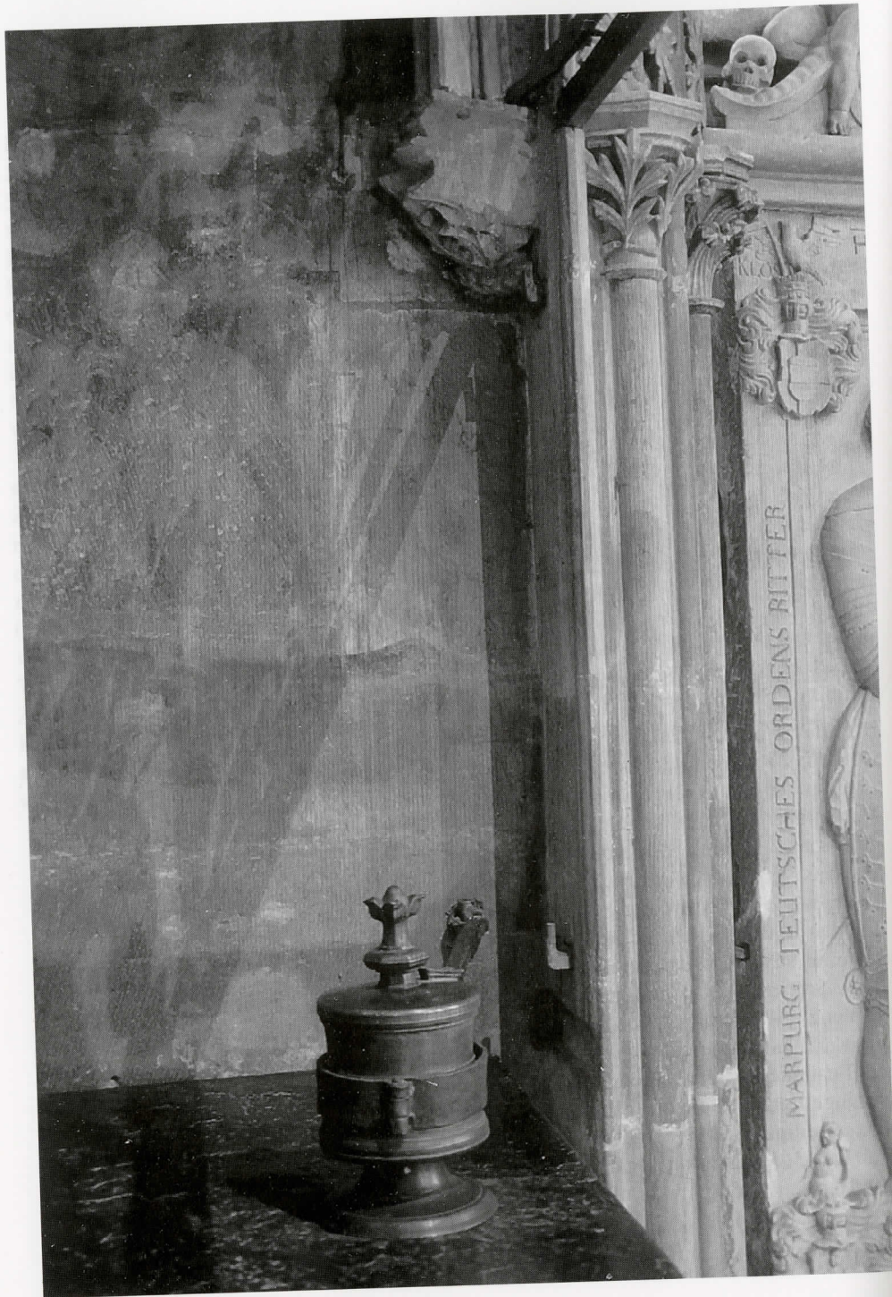
Abb. 31 Mausoleum, innere Rückwand, Opferbüchse, Reste der Freskierung und Abarbeitungsspuren an der Baldachinarchitektur anlässlich der Vergitterung
