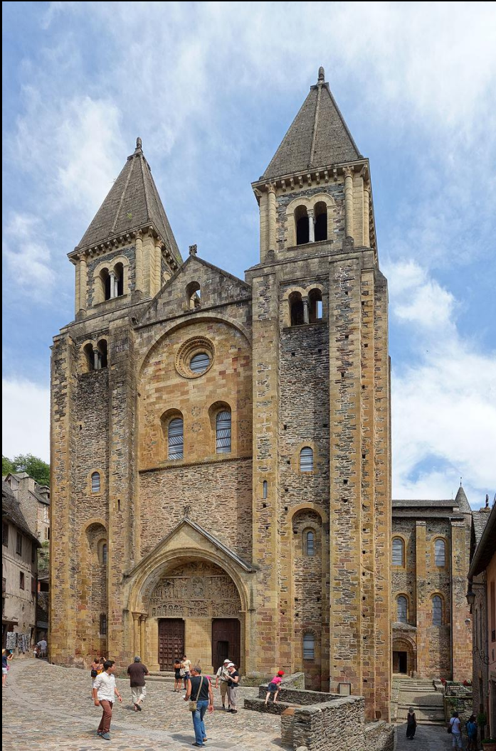
Klosterkirche von Sainte-Foy, Neubau 1040-1100 über Karolingischem Vorgängerbau
